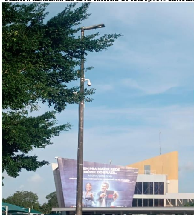
Figura 1 - Câmera instalada na área externa do Aeroporto Internacional Castro Pinto
